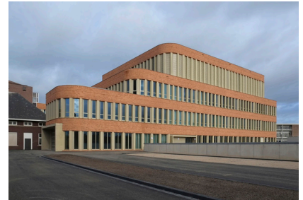
1204 WIEG Hotfloor LZR Roermond, Laurentius Ziekenhuis
